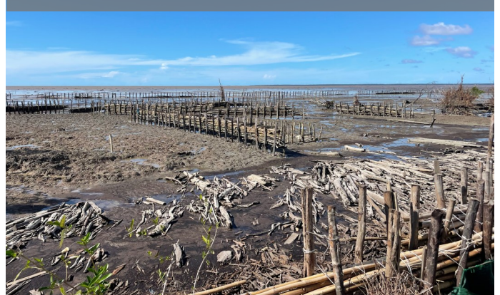
Sedimentretentieconstructies, ten noorden van Paramaribo, Suriname
